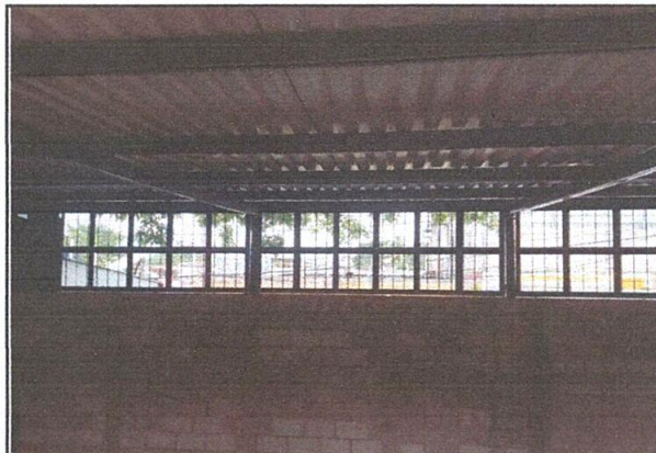
Foto 2: Cambio de ventanal
