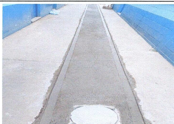
Foto 2: Cuneta para desagüe de aguas pluviales
