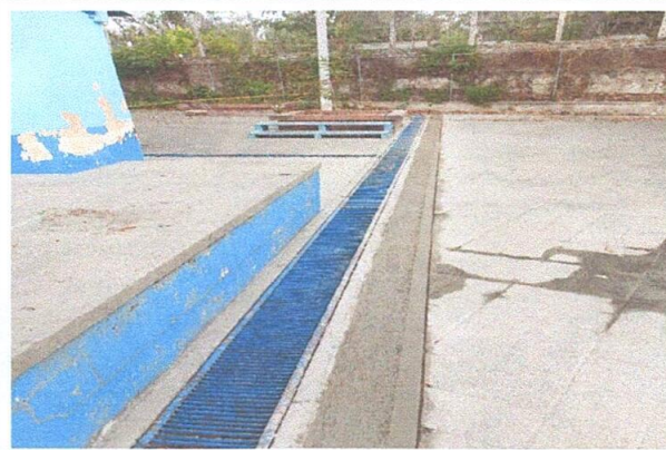
Foto 3: Cuneta de concreto
