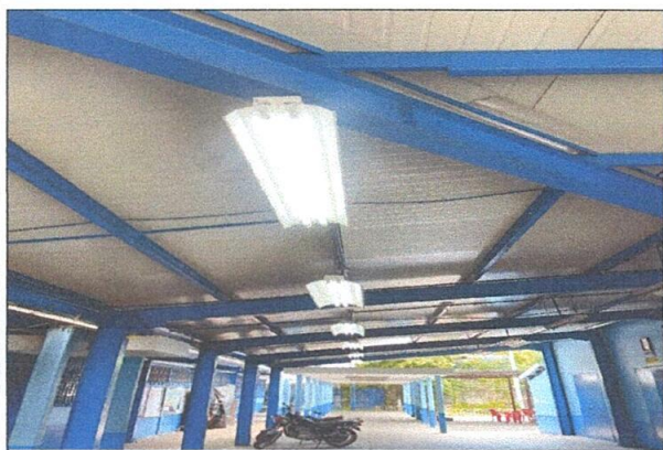
Foto 3: Reparación sistema eléctrico
