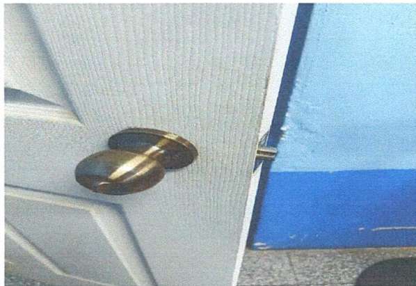
Foto 1: Cambio de chapas
