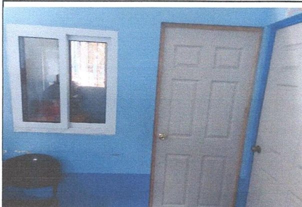
Foto 1: Instalación puerta y ventana
