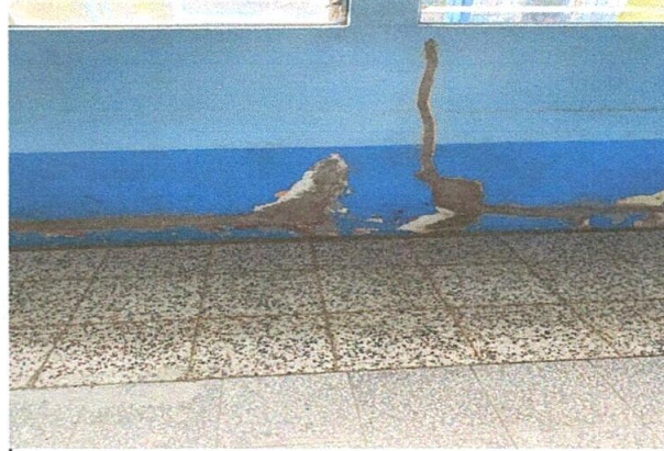
Foto 2: Reparación de pisos
