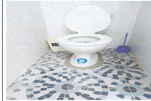
Foto 4: Servicios sanitarios y sus accesorios
